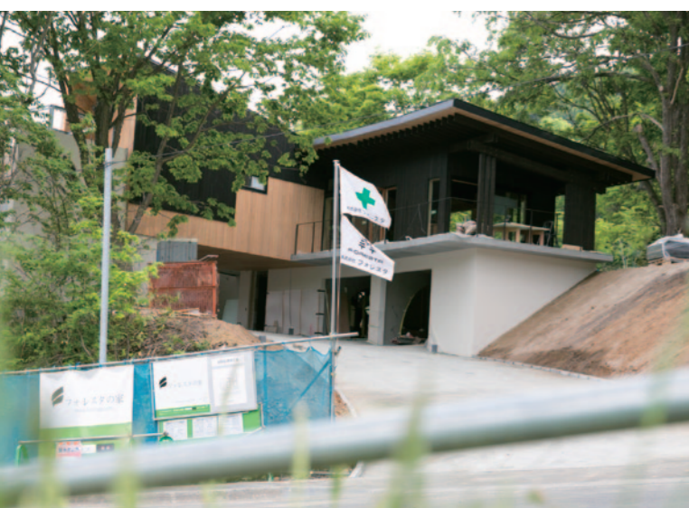
道路側から敷地を見る。車路も完成し、外構や内装も大詰め。7月の引渡しに向け仕上げ作業が続きます。
