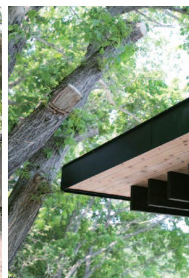
森の中の家づくりは、木々を残しながらの施工。
