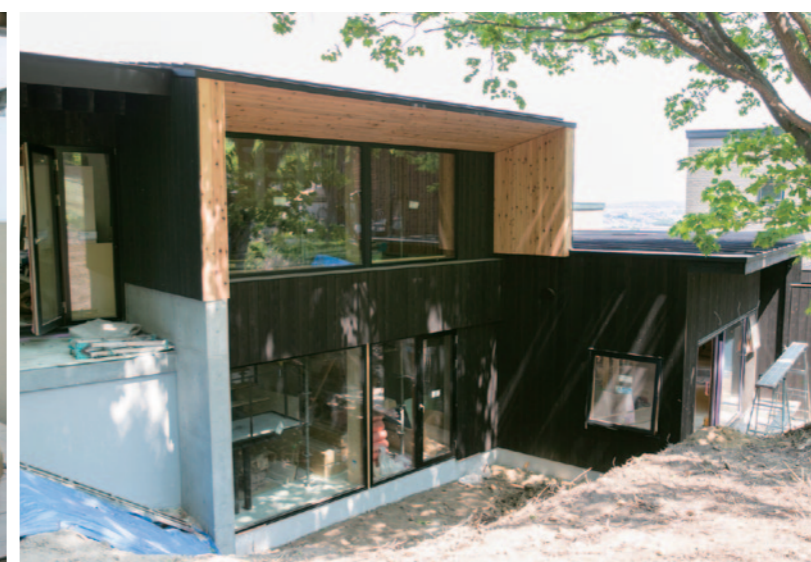
山側から建物中央の2層部分を見る。敷地の高低差に合わせて建物も平屋部分へと続く。
